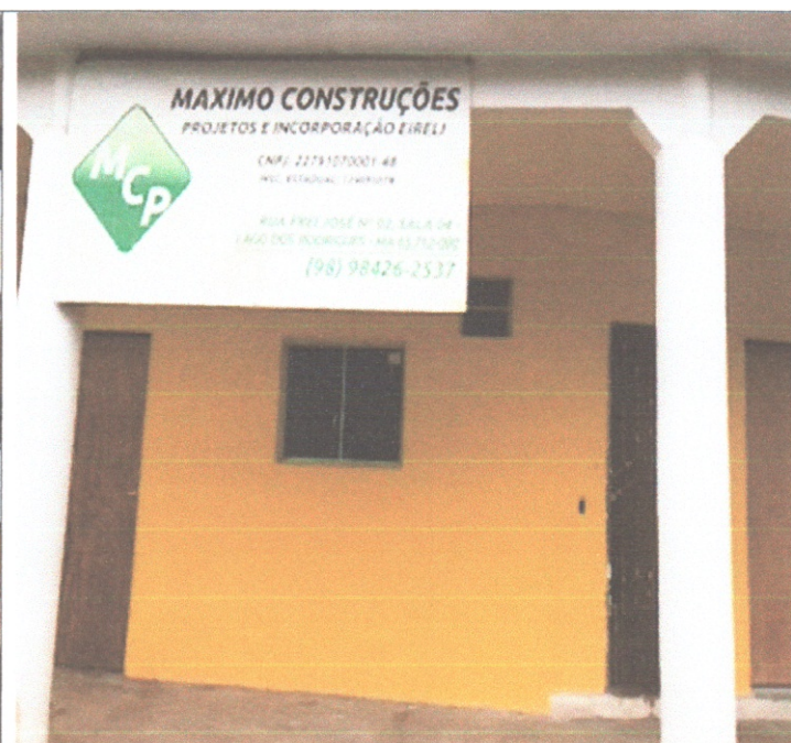
Foto 2 – Vista da fachada principal.
