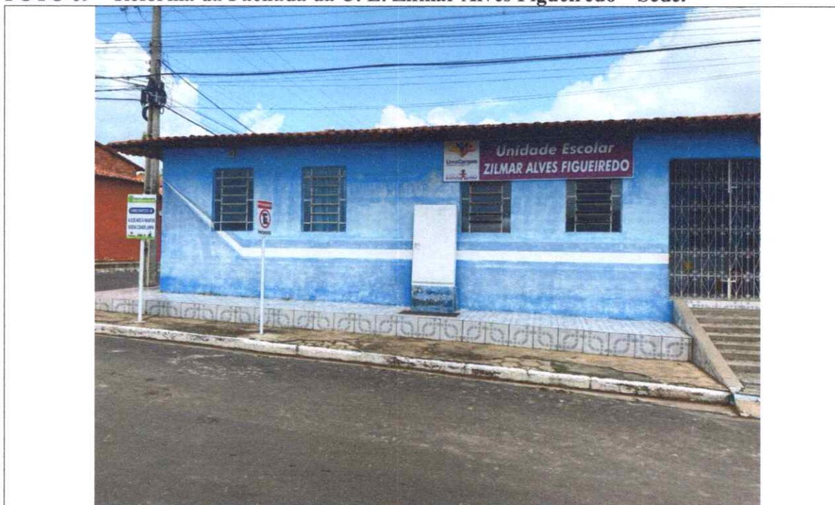
FOTO 09 – Reforma da Fachada da U. E. Zilmar Alves Figueiredo – Sede.
