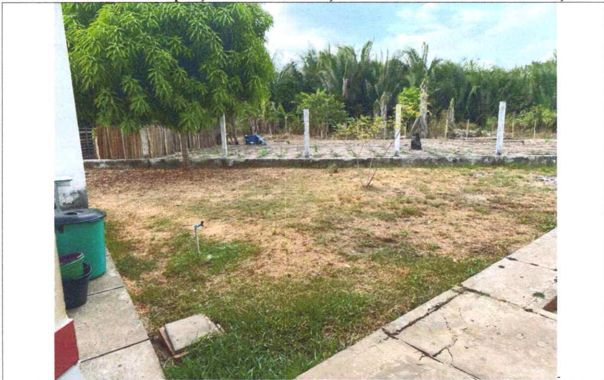
FOTO 13 – Reforma e ampliação da U. E Lourenço Coimbra – Povoado São Lourenço.
