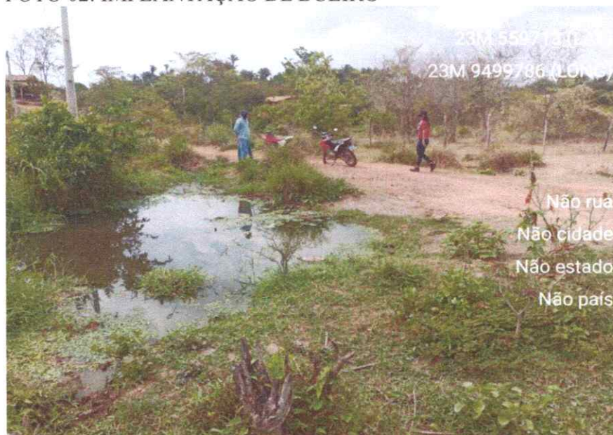
FOTO 02: IMPLANTAÇÃO DE BUEIRO
