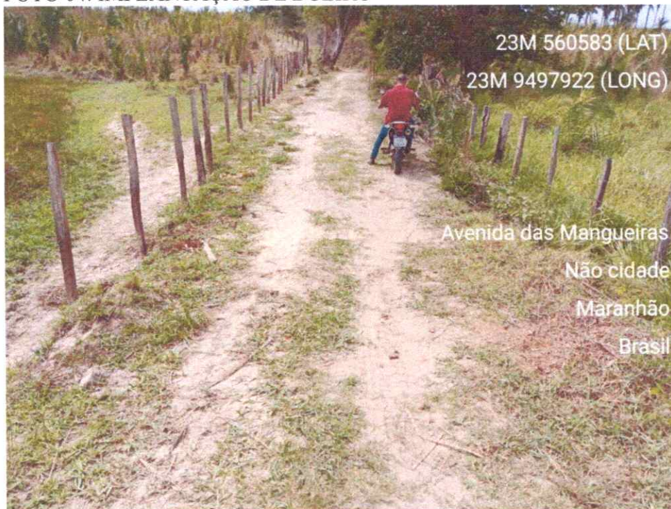
FOTO 04: IMPLANTAÇÃO DE BUEIRO
