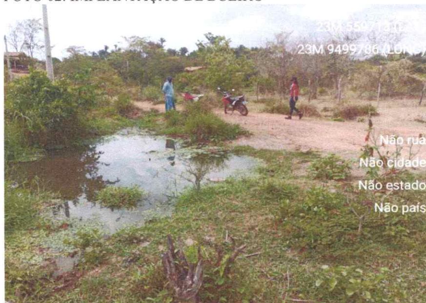
FOTO 02: IMPLANTAÇÃO DE BUEIRO
