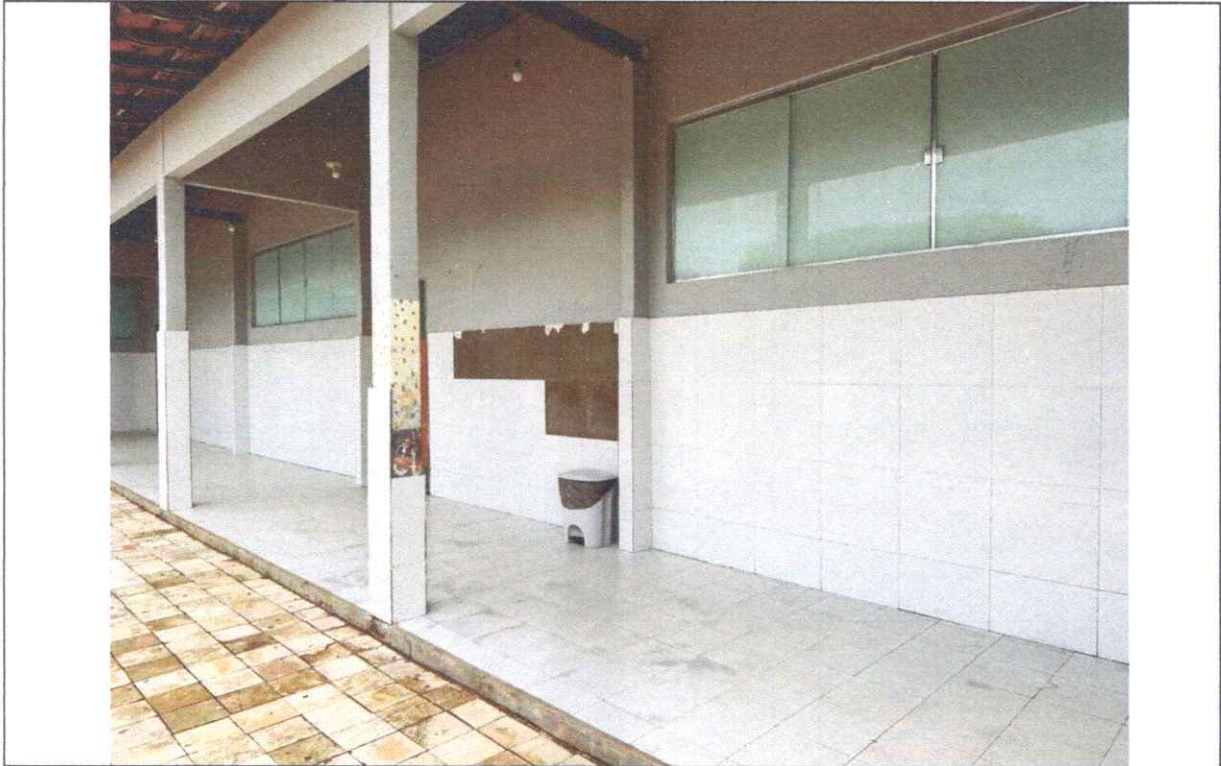
FOTO 05 – Unidade integrada Arthur Azevedo.
