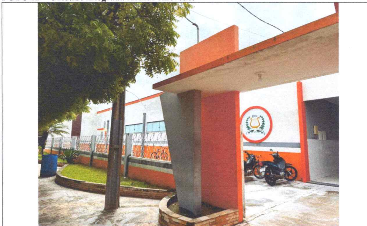
FOTO 02 – Unidade integrada Arthur Azevedo.
