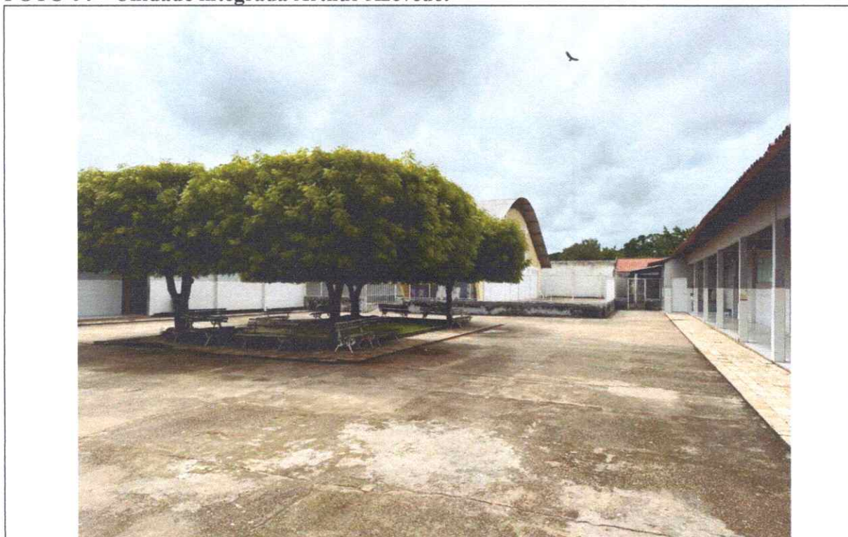
FOTO 04 – Unidade integrada Arthur Azevedo.
