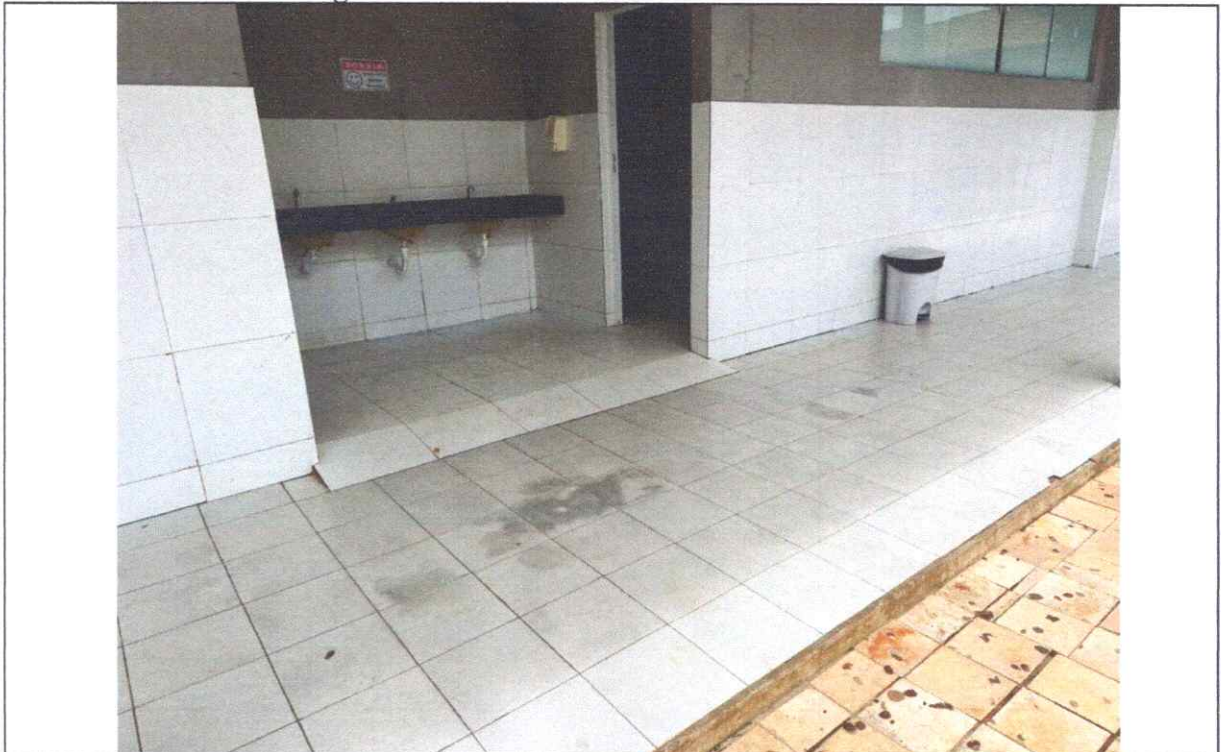
FOTO 06 – Unidade integrada Arthur Azevedo.
