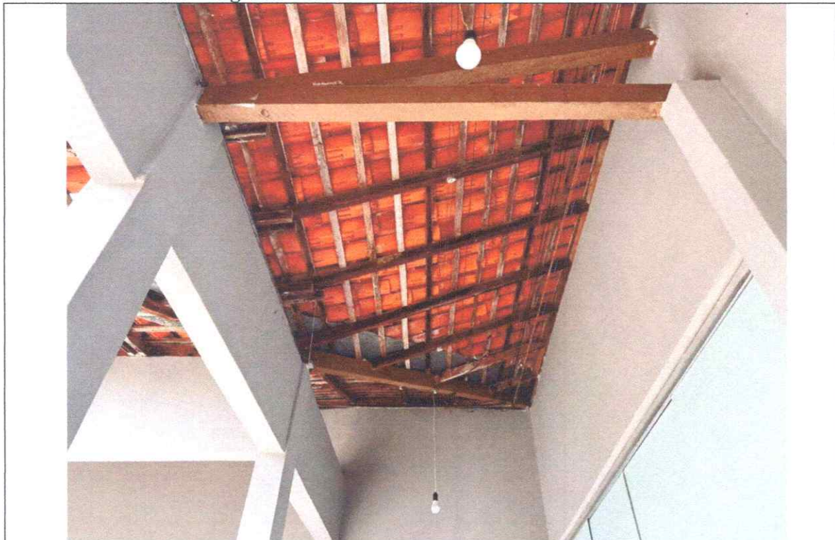
FOTO 03 – Unidade integrada Arthur Azevedo.
