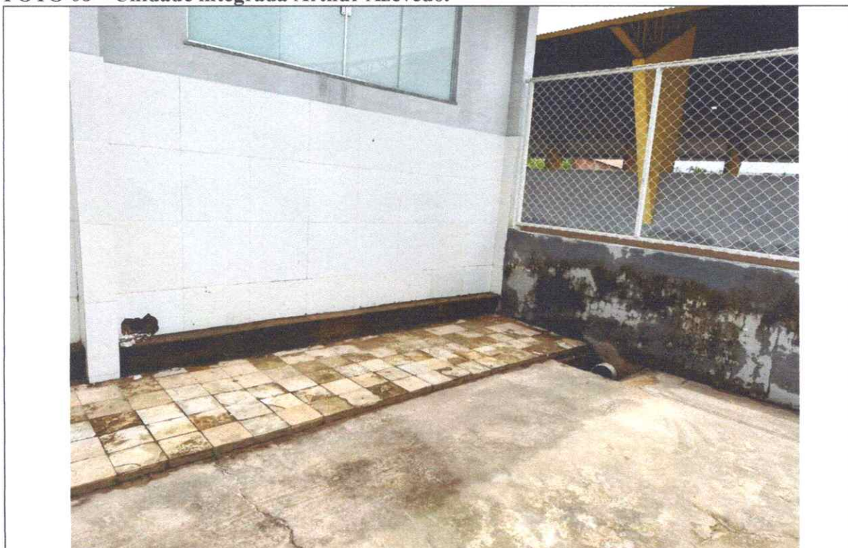
FOTO 08 – Unidade integrada Arthur Azevedo.
