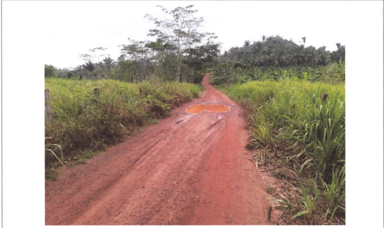
FOTO 03 – Estrada Vicinal – Pov. Santa Maria dos Magalhães.
