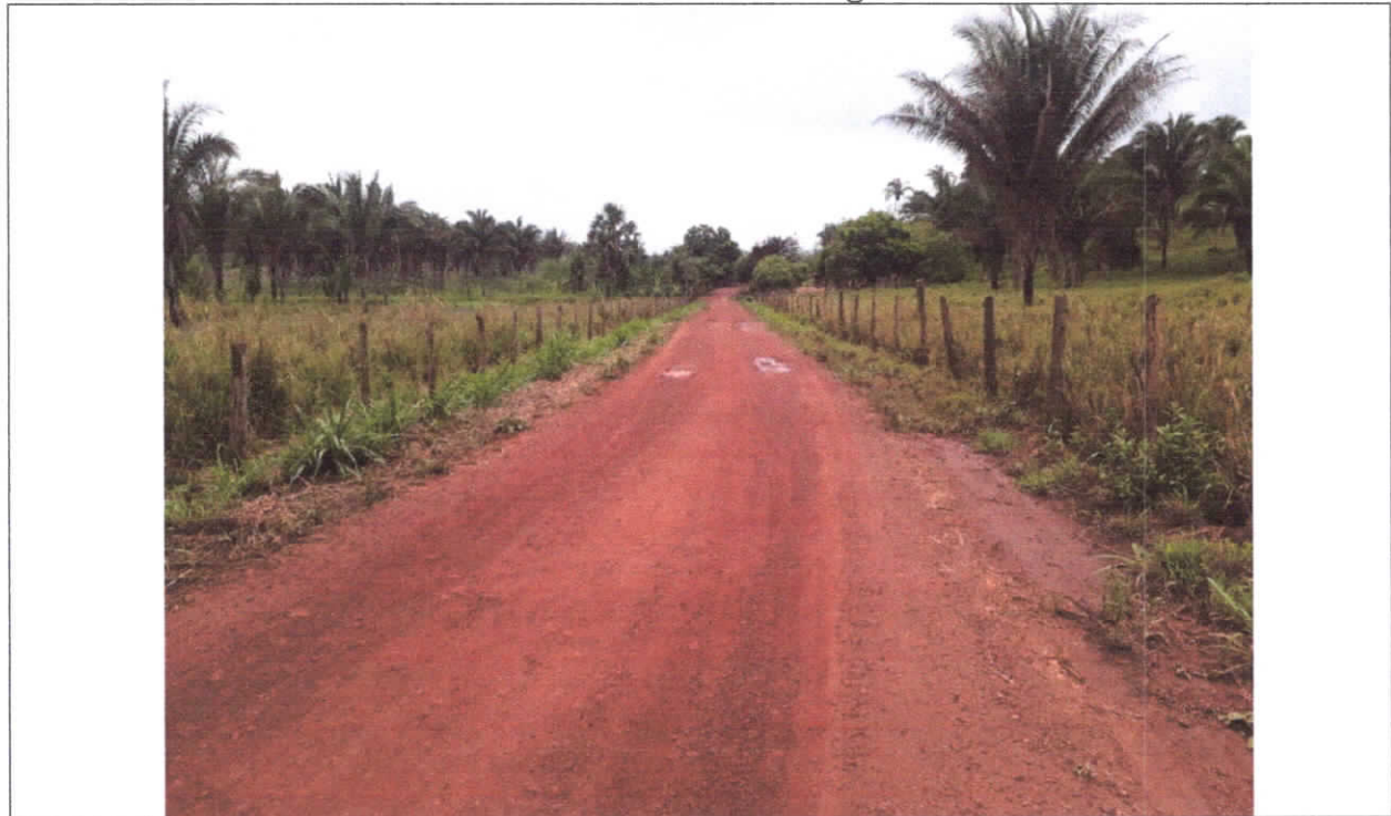
FOTO 04 – Estrada Vicinal – Pov. Santa Maria dos Magalhães.
