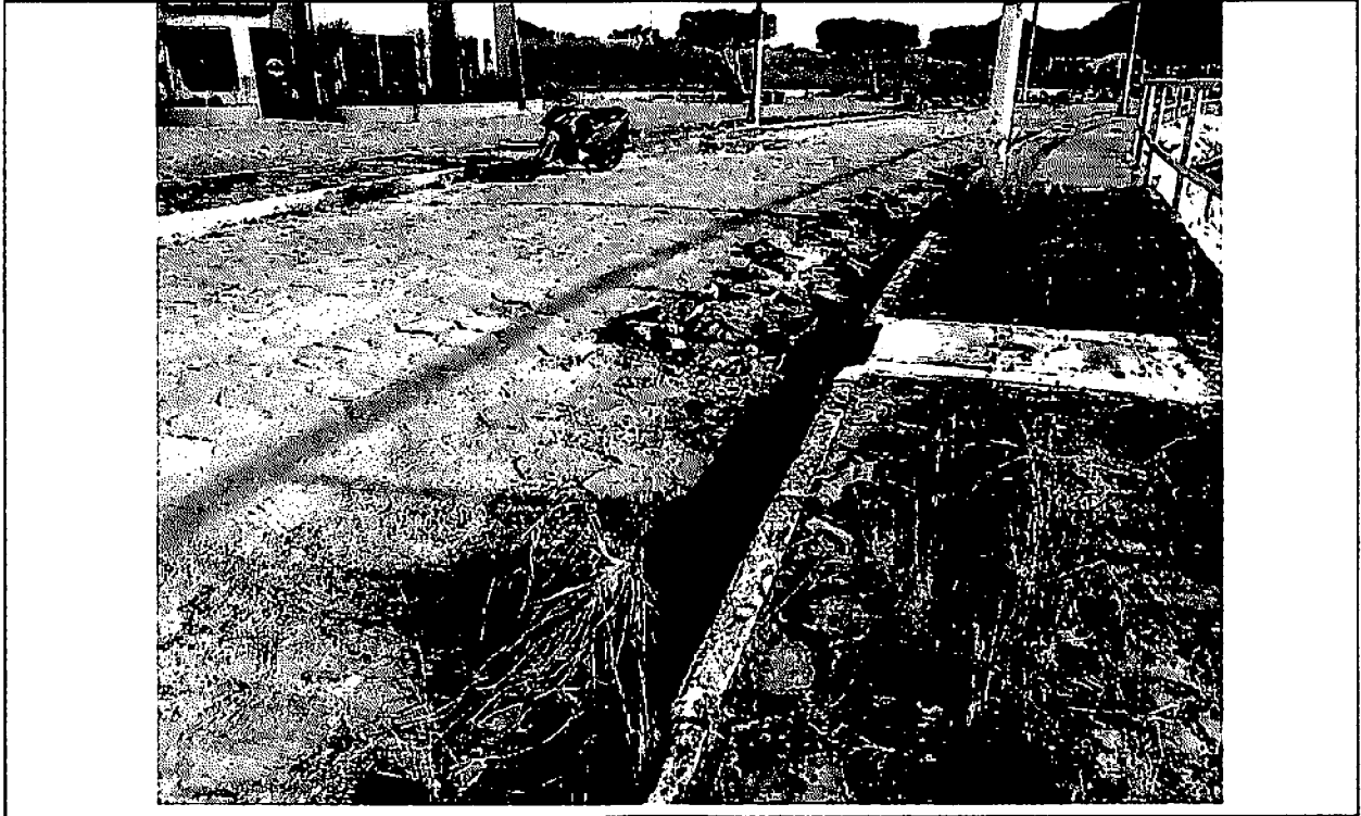
FOTO 03 – Drenagem Superficial e Calçada.
