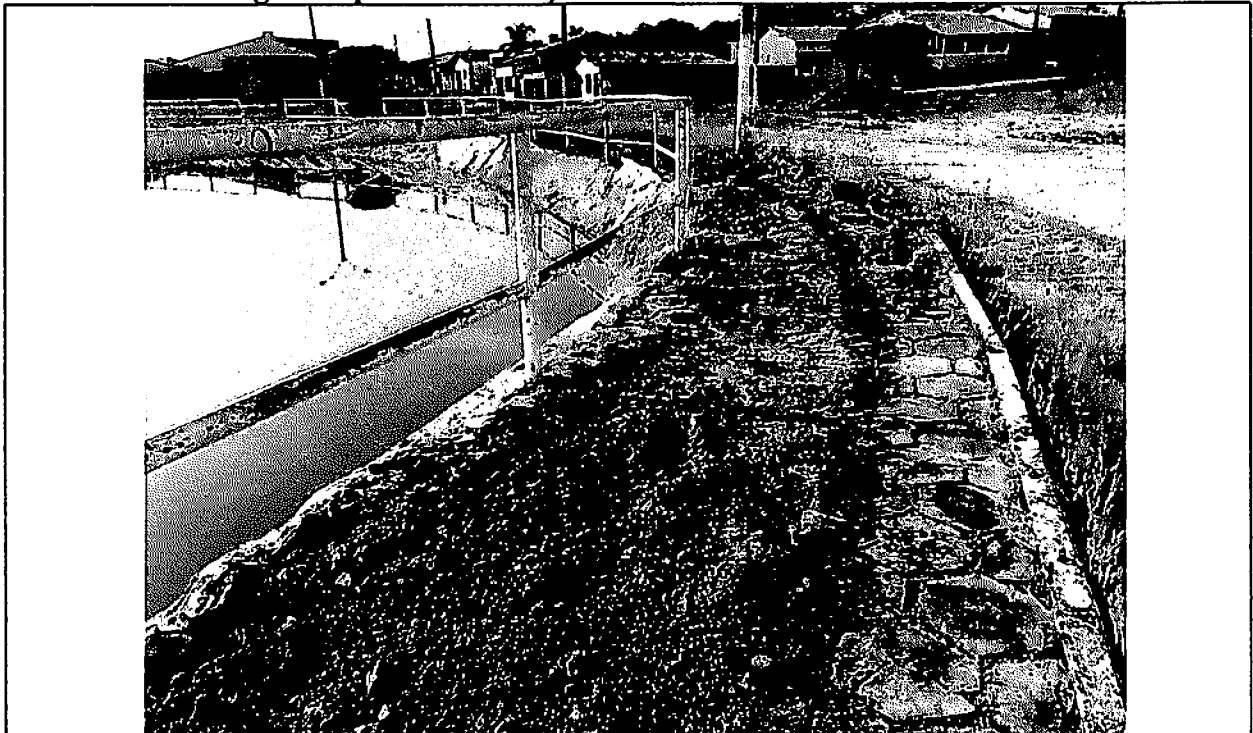
FOTO 04 – Drenagem Superficial e Calçada.
