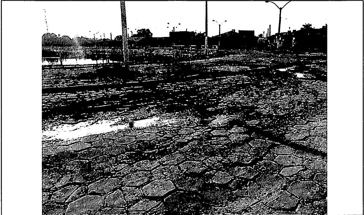
FOTO 01 – Pavimentação em Blocos Pré-moldados.
