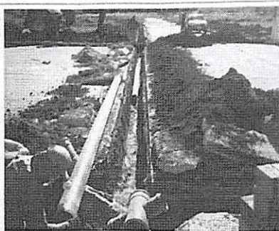
Foto 2: Implantação Rede de Distribuição de Água
