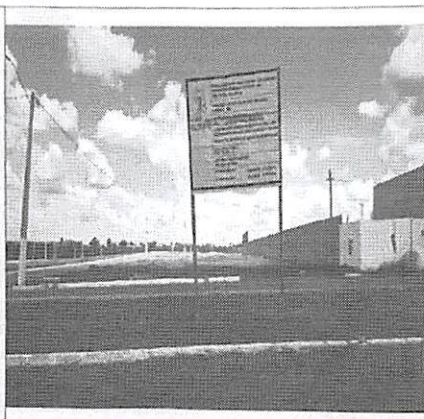
Foto 2: Placa da Obra
